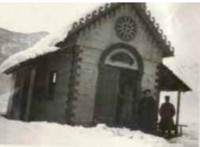
7. CALALZO (BL) - La Cappella sopra la stazione
